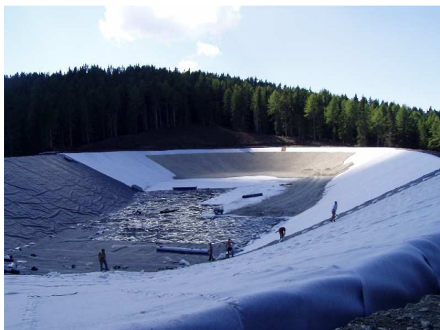
Figure 1/2. Cantiere per la costruzione del serbatoio di accumulo "Pracken" nel comprensorio di Plan de Corones e serbatoio "Rinneralm" in quello di Racines.
