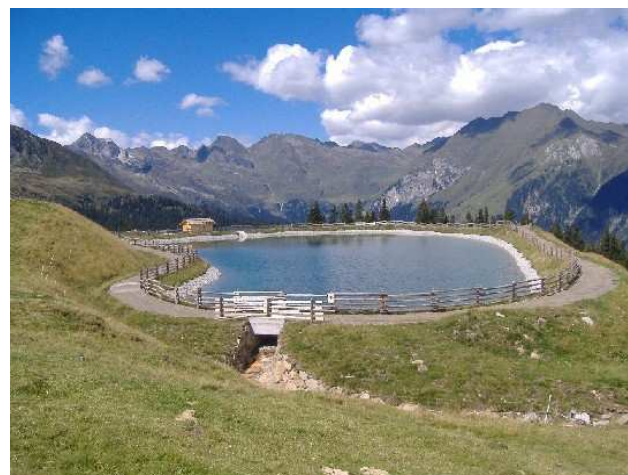
Abbildungen 1/2. Baustelle für den Bau des Speicherbeckens „Pracken“ am Kronplatz und Speicherbecken „Rinneralm“ im Skigebiet Ratschings
