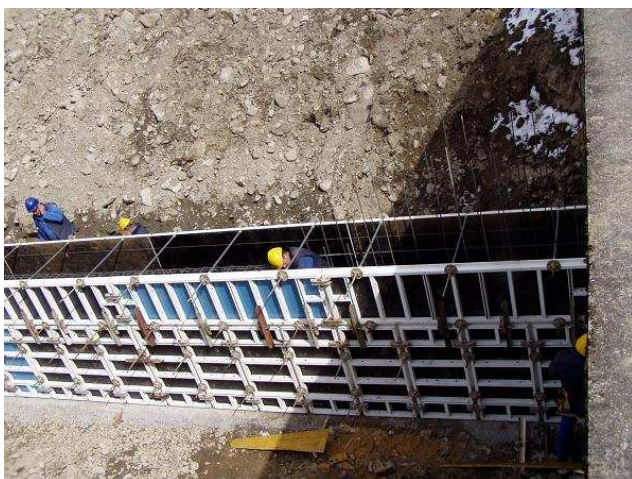
Figure 1/2. Cantiere per la realizzazione di una nuova stazione idrometrica sul rio Riva in località Caminata.
