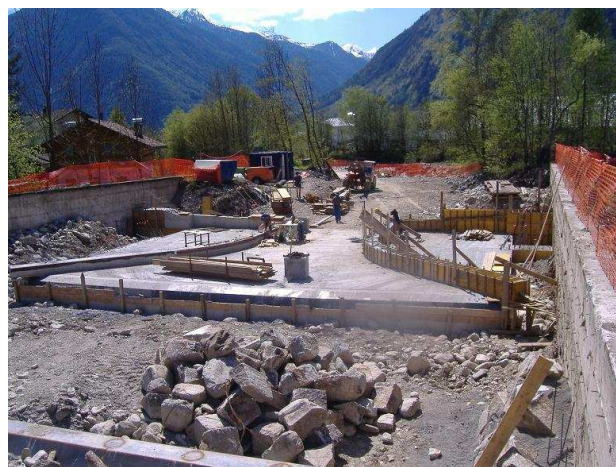
Abbildungen 1/2. Baustelle der neuen Pegelstation am Reinbach in Kematen.
