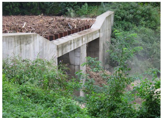
**Abbildung 6/7.** Das Hochwasser des Schaldererbaches in Richtung der Ortschaft Vahrn (links) und der Rückstau von Holz an einem Wehr am Tinnebach (rechts).
