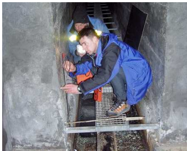
Abbildungen 1. /2. Gesamtes Wasserschutzgebiet der Confinquellen unter der Langkofelgruppe und Detailansicht einer Wasserführungsmessung im Fassungsbauwerk.
