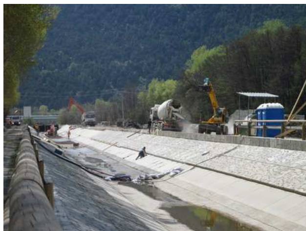
Abb. 1/2 Ausgleichsbecken Schluderns von oben - Oberflächenerneuerung am Zulaufkanal
