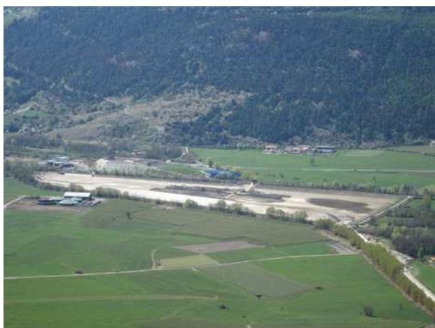
Fig. 1/2: Veduta aerea della vasca di compensazione di Sluderno e risanamento del canale di adduzione.
