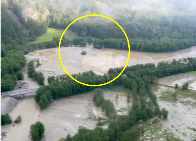
Abb.1/2 Überschwemmung Zone Ried im Pfitschertal Rest des Messsteges - das betonierte Brückenaufleger
