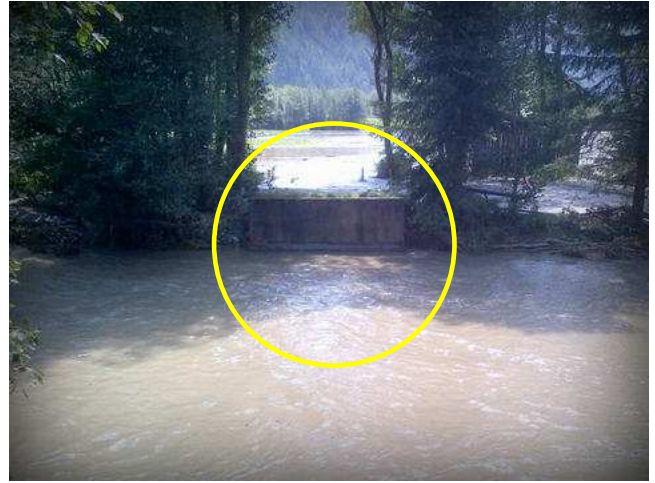
Fig.1/2 Alluvionamento della zona di Novale in Val di Vizze e spalla della passerella di misura presso la stazione idrometrica ivi ubicata.
