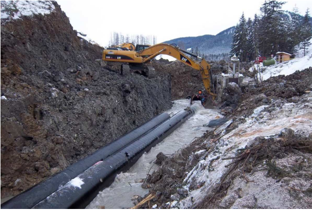
Abb 1 Bau Umleitung an der Gader bei St. Leonhard Abb 2 Wasserstandslinie unterhalb Hangrutschzone
