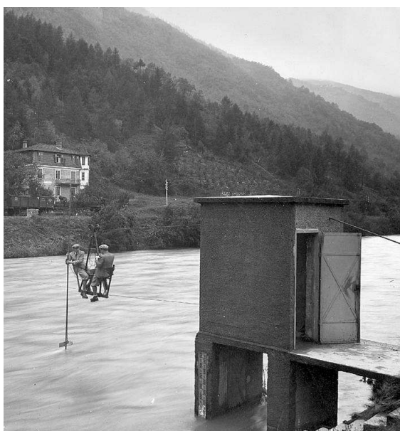
Figure 1./2. Stazione idrometrica Adige a Tel e mulinello idrometrico storico.
